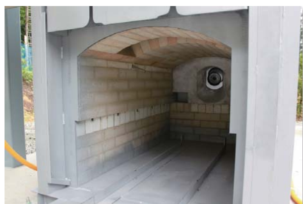
火葬室内：台車無し 炉頂部分のアーチ積み、空気孔部分の 特殊煉瓦、背面部分の耐火セメントなど耐火・耐久性を熟慮。
