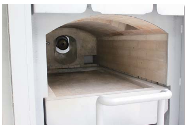
火葬室内：台車格納時 (写真奥がバーナーの照射口) 燃焼ガスは炉頂手前部分から排ガス処理室へ。
