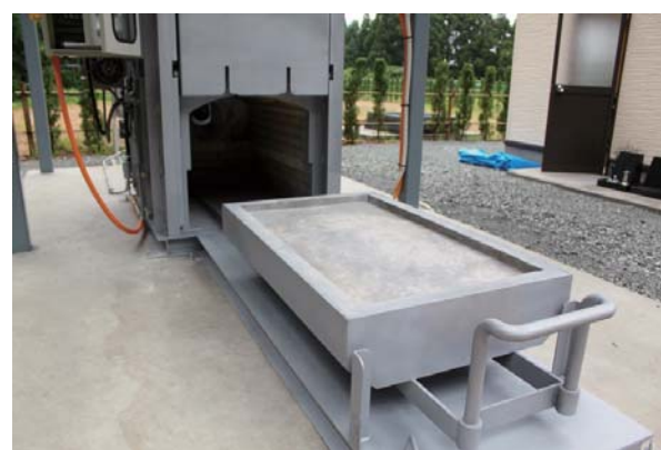
台車：油漏れ防止設計 シームレスな耐火セメント打設。
